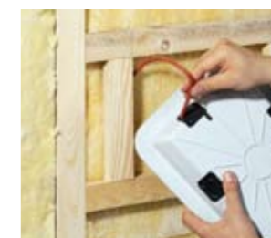
Installatie met binnenliggende raveling.
