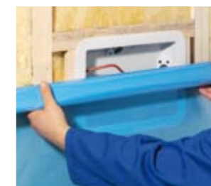
Installatie met binnenliggende raveling.
