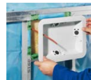
Installatie met opliggende raveling.
