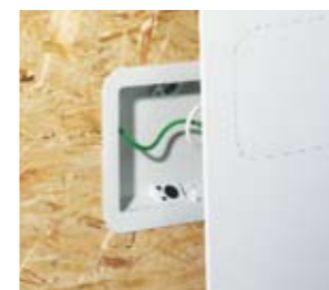
Installatie met OSB-plaat.
