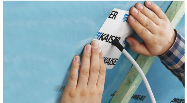
Manchet opplakken en grondig van binnen naar buiten op de ondergrond vaststrijken.
